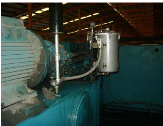
รูปที่ 1. ภาพการติดตั้งเครื่องฟอกน้ำมันไฮดรอลิก Puradyn กับเครื่องเพรสโลหะแผ่น
