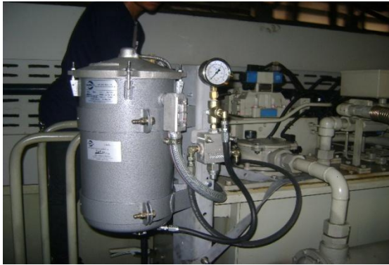
รูปที่ 1. ภาพการติดตั้งเครื่องฟอกน้ำมันไฮดรอลิก Puradyn กับเครื่องเพรสโลหะแผ่น
